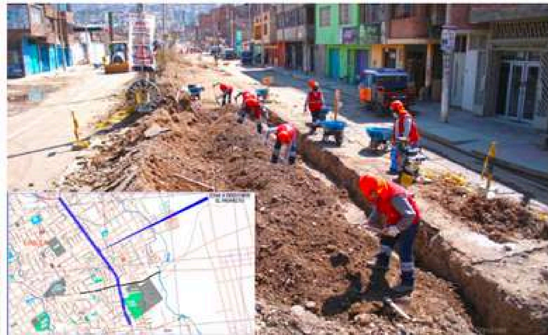
Agua potable y alcantarillado sanitario de la Av. Próceres
